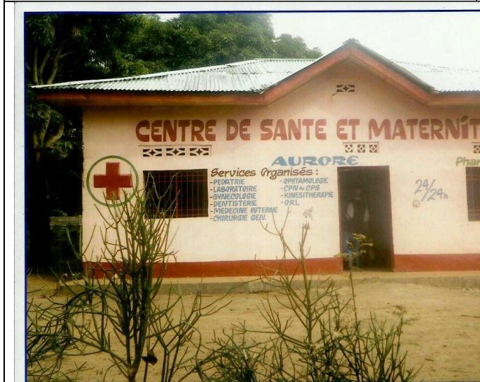
A lavori conclusi
