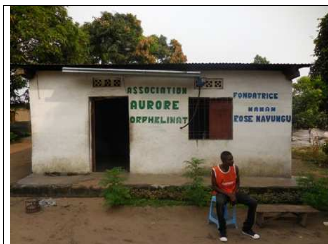
Prima dei lavori
